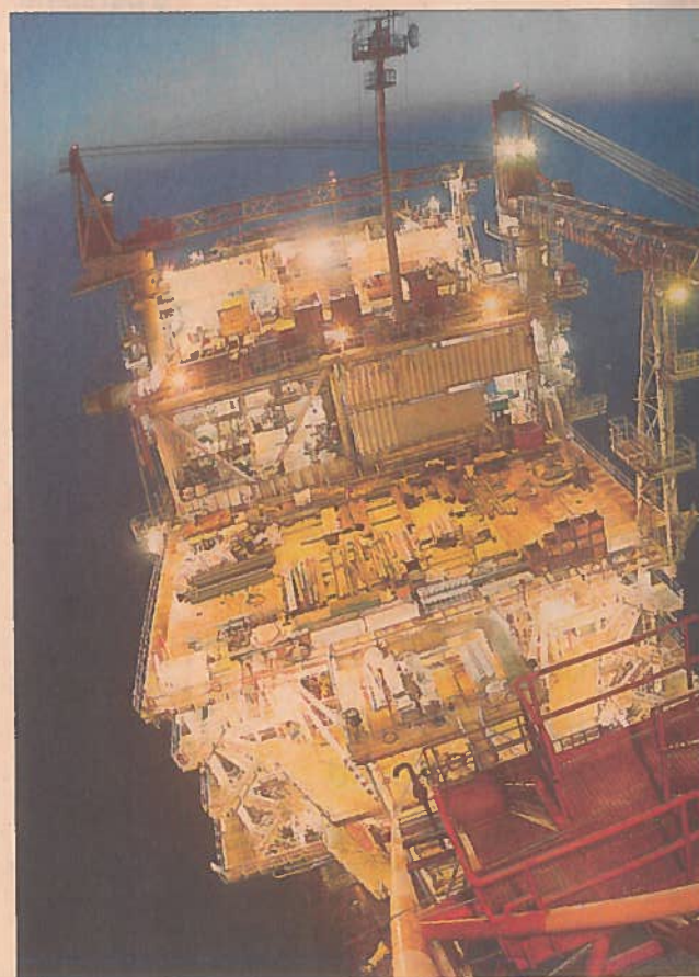
Nel guado tra idrocarburi e rinnovabili. La piattaforma offshore di Edison
